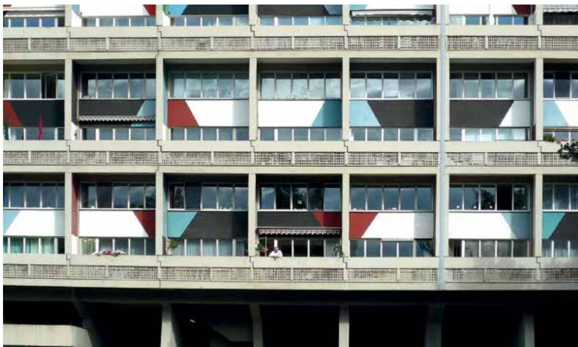
Das Corbusierhaus in Berlin: Im Erdgeschoss wurde auf Wohnungen verzichtet, hier stehen die tragenden Wände frei und dienen als Garagenstellplätze.
