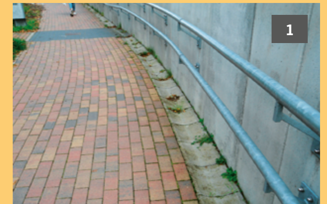
Mit zusätzlichem Handlauf kann so manches Gefälle sicherer gestaltet werden, auch wenn die Regenrinne zu einer Stolperfalle werden kann
